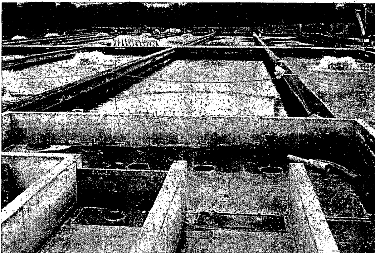
Fig. 14: Partie supérieure amont d'une chambre à oxygène. Vue des pompes amenant l'eau à traiter
