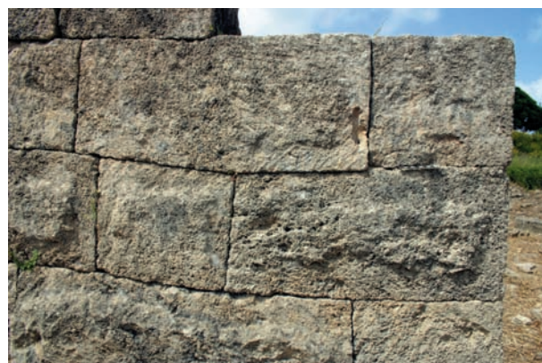
Figure 7. Résidence de Yabninou, d'Ougarit angle nord-est, blocs assemblés à la scie à joint (© cliché J.-C. Bessac).
