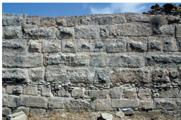
Figure 6. Mur sud du Palais royal d'Ougarit composé de blocs à bossage d'économie et assemblés en alternant l'obliquité de leur profil trapézoïdal (© cliché J.-C. Bessac).
